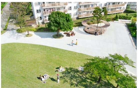
外観・屋外空間リノベーション ようこうだい 洋光台団地（神奈川県）「団地の未来」プロジェクト
